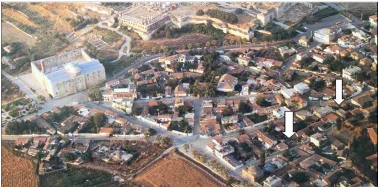
Fotoğraf 1. Ayasuluk kent merkezi: İsabey Camii, Hamamı ve 1058 Sokak'ta Kılıçaslan Camii ve 1. Zaviyeli Cami ve 2. Zaviyeli Cami (okla gösterilmiş). / Ayasuluk city center: İsabey Mosque, İsabey Hamam and Kılıçaslan Mosque and 1st Zawiya Mosque and 2nd Zawiya Mosque on 1058 Street.
