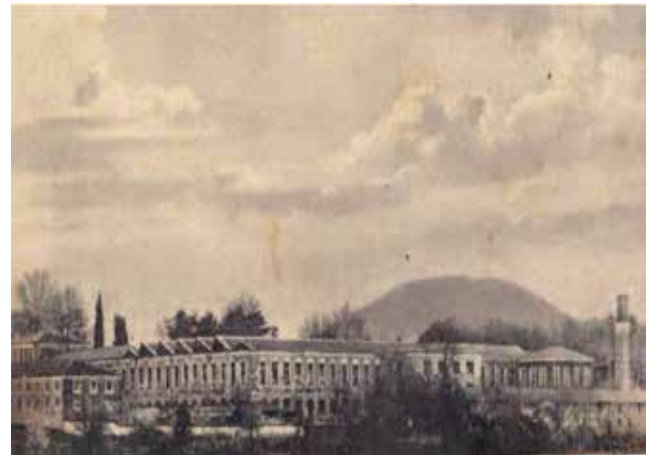
Fotoğraf 1. Çuha Fabrikası'nın (Çuha Fabrika-i Hümayun) Genel Görünümü-1901. / General view of the Cloth Factory (Çuha Fabrika-i Hümayun)-1901 (Dölen, 1992).
