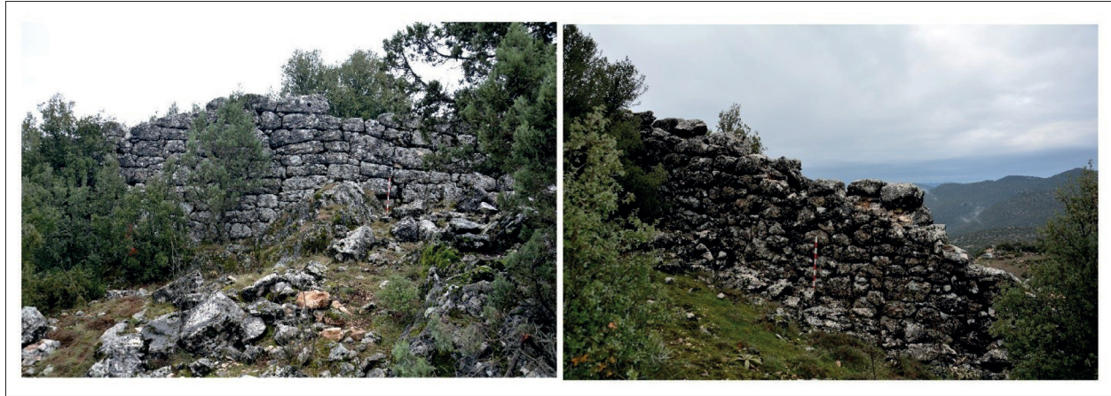
Figür 14. Keraitai, batı sur dıştan ve iç taraftan görünüm / Ceraitai, west wall exterior (left) and interior view.
