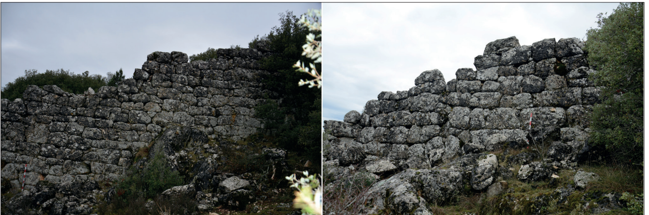
Figür 27. Keraitai, çokgen ve kıklopik taşların arasına küçük taşların yerleştirildiği duvar tipi / Ceraitai, type of masonry in which small stones are placed between polygonal and cyclopean stones.
