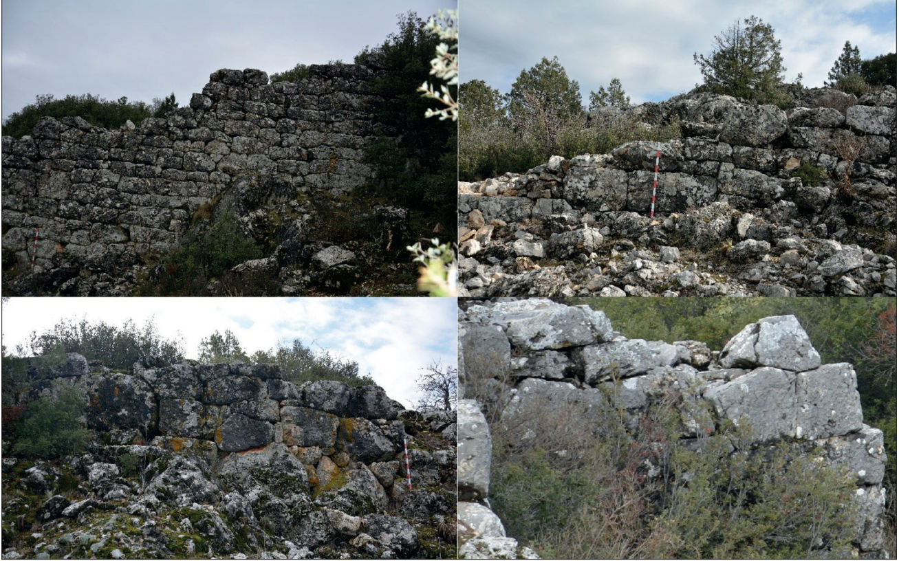
Figür 23. Keraitai, Duvar örgü tipleri (üst sol (a, b, c, g), üst sağ (f, h), alt sol (c-e), alt sağ (d) / Ceraitai, Masonry types (top left (a, b, c, g), top right (f), bottom left (c-e), bottom right (d)).
