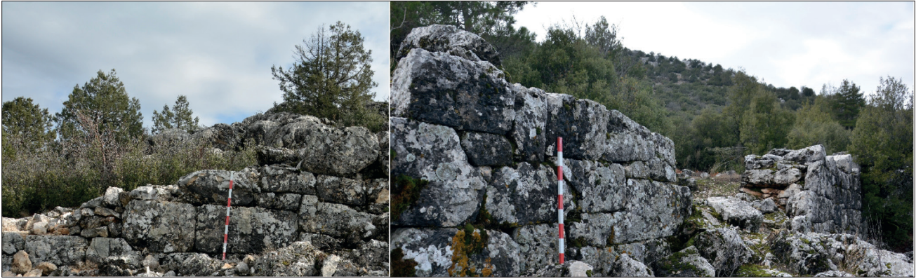
Figür 28. Keraitai, onarım izleri / Ceraitai, traces of repair:
