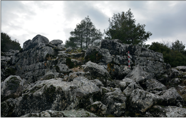
Figür 12. Keraitai, kuzey-doğu surları birleşimi / Ceraitai, junction of north-east walls.
