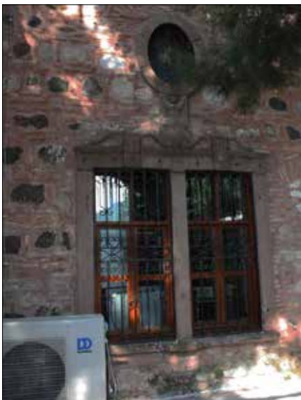
Photo 9 - Western lower twin window's mouldings; volutes and a crescent motif in the middle of them. / Batıdaki alt ikiz pencere süslemeleri; volütler ve ortalarındaki hilal motifi.
