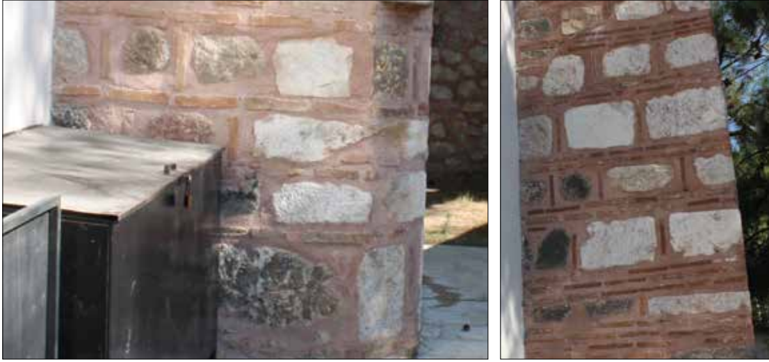
Photo 11 - Northern wall of the kürsü of the minaret, lower part (left) and upper part (right). / Minare kürsüsü kuzey duvarı, alt kısım (sol) ve üst kısım (sağ).
