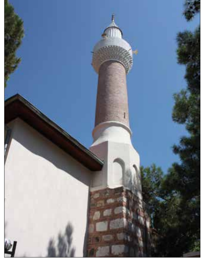
Photo 17 - The minaret, plastered portions, before (left) (RDPE, 2008) and after the 2013 restoration (right). / Minare, sıvalı kısımlar, 2013 restorasyonu öncesi (sol) ve sonrası (sağ).
