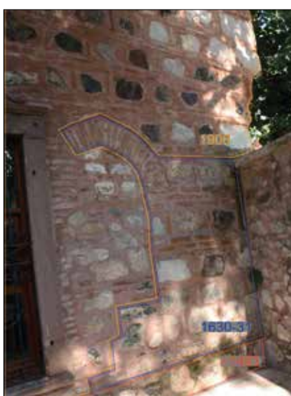
Photo 10 - Three different types of construction technique seen at the western wall of the Prayer Hall / Harim batı duvarında görülen üç farklı yapıım tekniği.
