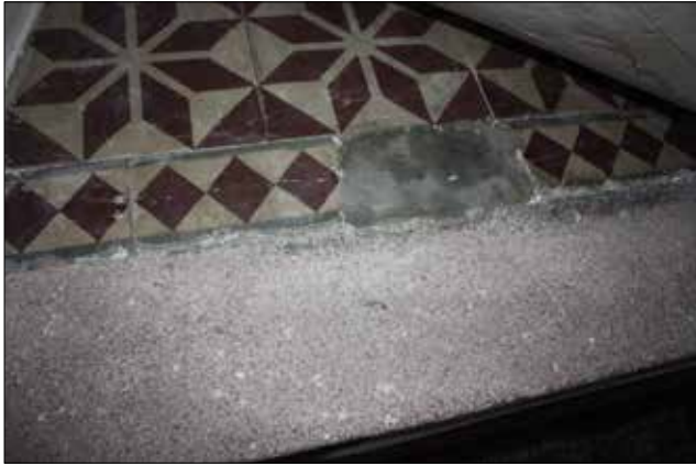
Photo 12 - Reintegration of sill covering with cement mortar instead of mosaic. / Denizliklerin mozaik yerine çimento harcı ile bütünlenmesi.
