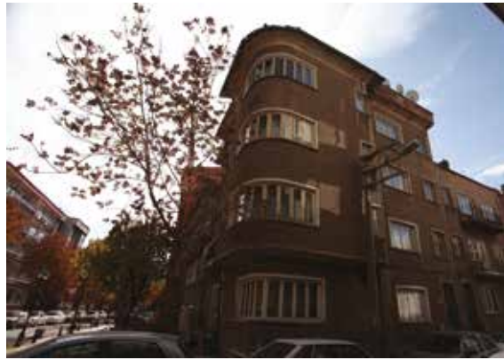
Levha 9 - Deliktaş Mahallesi apartmanları (Eskişehir Modern Mimarlık Sergisi, Alper Elitok arşivi). / The apartments in Deliktaş District (Eskişehir Modern Architecture Exhibition; archive of Alper Elitok)
