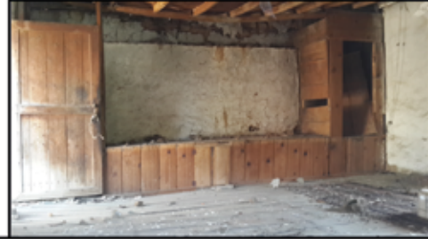
Foto. 6: Odada yer alan yüklük ögesi. Photo 6: Cupboard from one of the rooms.
