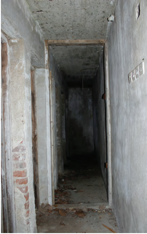
Fotoğraf 29 - Koridordan girilen ıslak hacimler / Toilets entered from corridor
