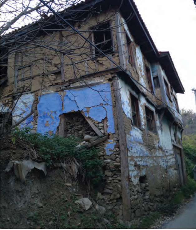
Fotoğraf 4 - Üçgen çıkma ve eliböğründelerin görünümü / Triangular cantilever and the view of the timber supports (Bağbancı, 2015)
