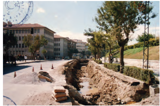
Fotoğraf 13 - Alaeddin Tepesi'nin güneyinde, hafif raylı sistem hatlarının inşası için 1990 yılında yapılan kazılardan bir görüntü. (T.C. Kültür ve Turizm Bakanlığı , Kültür Varlıkları ve Müzeler Genel Müdürlüğü arşivi) / A view from the excavations in 1990, for the construction of public railway system to the south of Alaeddin Hill. (Archives of the Ministry of Culture and Tourism, General Directorate of Cultural Properties and Museums)
