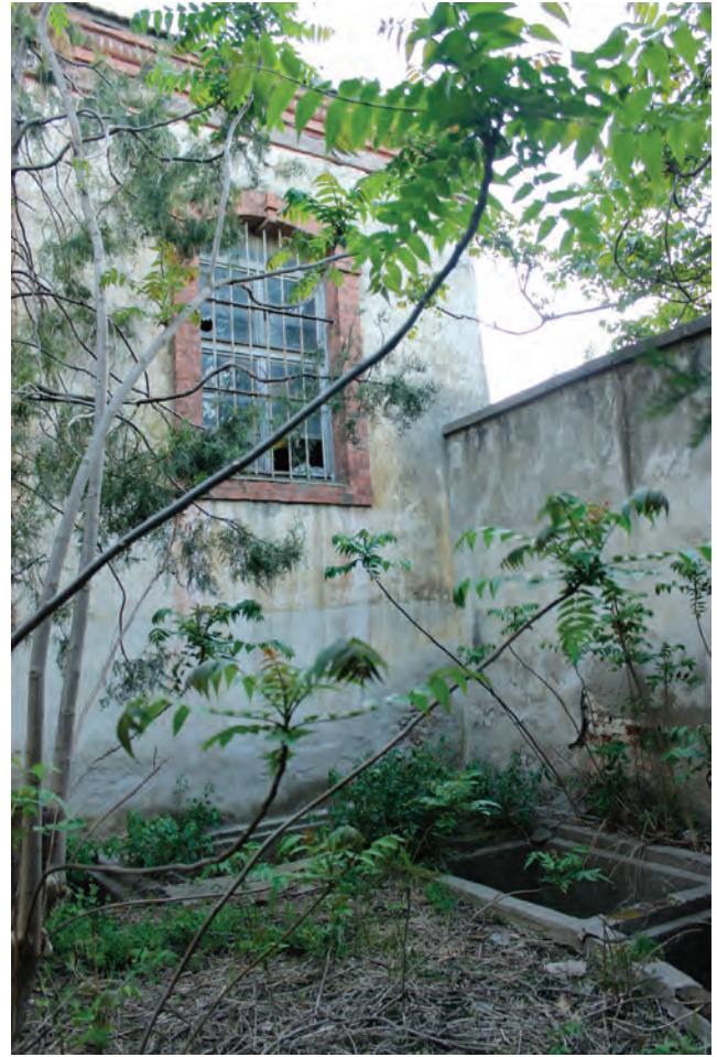
Fotoğraf 19 - Kuzeydoğu cephesi, bahçe zemininde karasu havuzları / Northeast facade, olive wastewater pools in the ground
