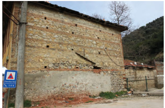
Fotoğraf 34 - Marangozhane güneybatı cephesi / Southwest facade of the Carpenter's workshop
