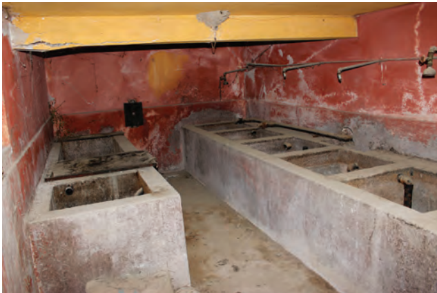
Fotoğraf 17 - Z08 Zeytinyağı ayırıştırma havuzları (polima) / Z08 Olive oil separation pools (polima)
