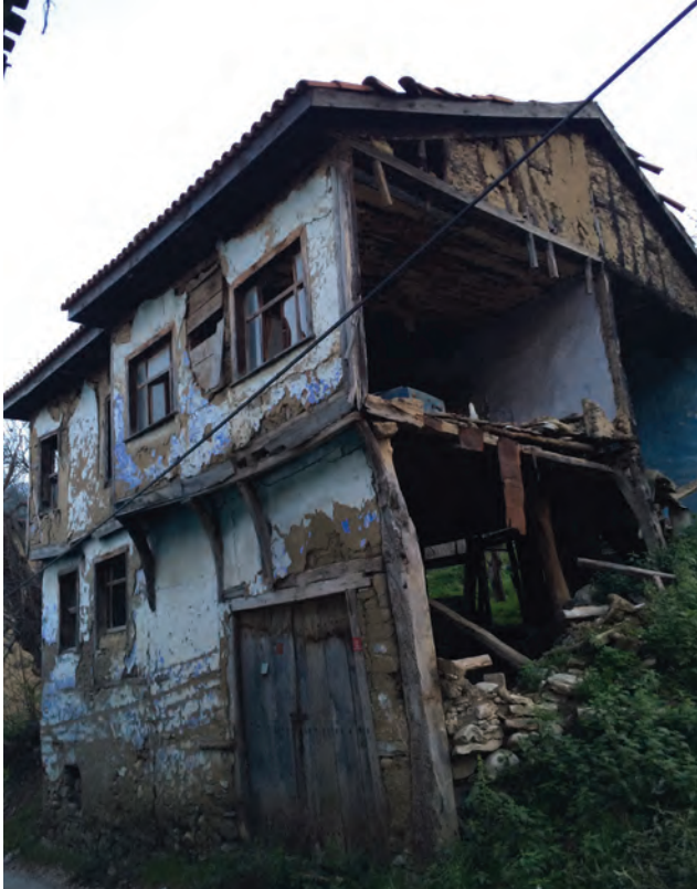
Fotoğraf 2 - Yapının kuzeybatı görünümü / View of the northwest facade. (Bağbancı,2015)
