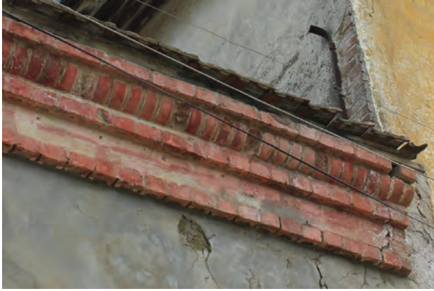
Fotoğraf 22 - Zeytinyağı fabrikasının tuğla saçak silmesi detayı / Brick eaves moulding of olive oil factory
