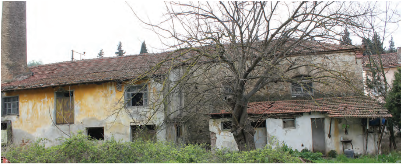
Fotoğraf 24 - Zeytinyağı fabrikası güneydoğu cephesi ve müştemilatlar / Olive oil factory southeast facade and outbuildings
