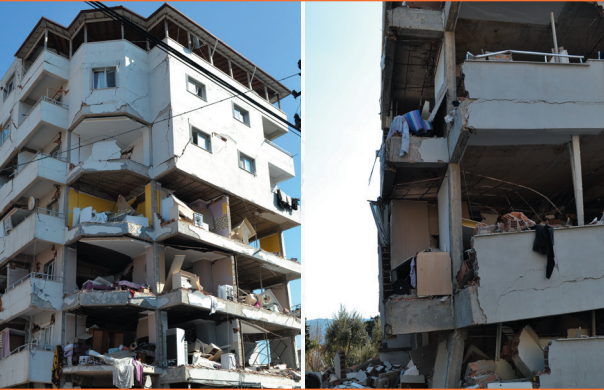
Fotoğraf 7. Taşıyıcı sistemde sürekli kiriş oluşturulmaması ve meydana gelen hasar.
