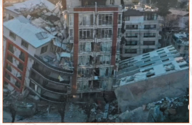
— Fotoğraf 17. Köşe parsellere yapılmış, ortogonal olmayan binaların deprem öncesi ve sonrası durumları
