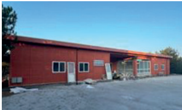
Şekil 15. İYA-bazlı jeopolymer beton ile üretilmiş tamamen sökülüp-takılabilen konut inşaatı (Newton 2020 Ülke ödülü – Hacettepe Üniversitesi)
