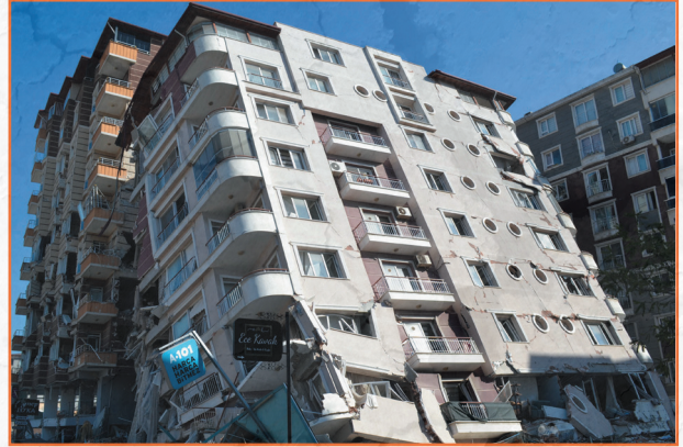
Fotoğraf 11. Yumuşak kat oluşumu
